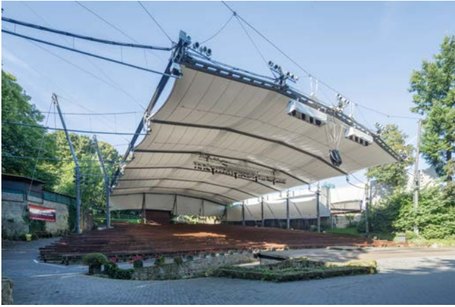
Bild 2 Dach nach der Sanierung im geschlossenen Zustand (Quelle: R. Borgmann) Roof after refurbishment in closed position
