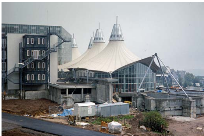
Bild 9 Fertig­ge­stelltes Membrandach 1994 (Quelle: formTL) Completed membrane roof in 1994
