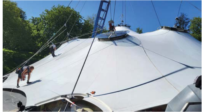
Bild 7 Lackierarbeiten Membrane (Quelle: formTL) Varnishing work membrane
