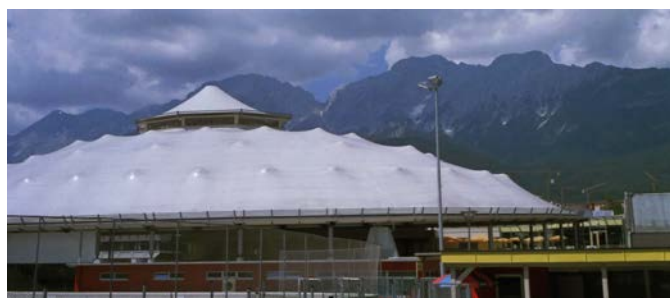
Bild 13 Membrandach kurz nach der Fertigstellung (Quelle: formTL) Membrane roof shortly after completion
