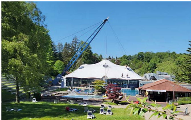
Bild 8 Abschluss der Renovierungsarbeiten (Quelle: formTL) Completion of the renovation work
