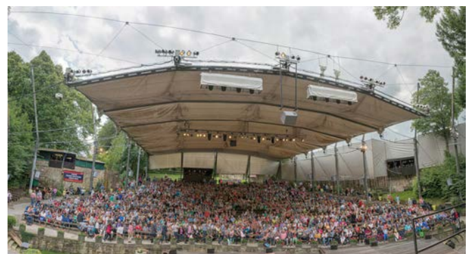
Bild 1 Dach vor der Sanierung während einer Aufführung (Quelle: Freilichtbühne Tecklenburg) Roof before refurbishment during a show
