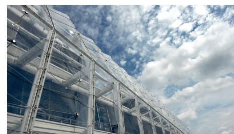
Die Vorhangsfassade verhindert unerwünschten solaren Energieeintrag, da die so geschützten Sonnenschutzlamellen auch bei starkem Wind und Sonnenschein verwendet werden können. Die Vorhangsfassade besteht aus 224 Paneelen. Die einzelnen Paneele bilden jedes für sich ein abgeschlossenes Konstruktionssystem. Basis ist ein biegesteifer Rahmen aus Hohlprofilen, der mit einer silberverstärkte ETFE-Folie bespannt ist.
