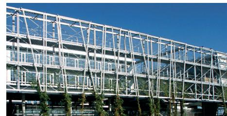
Für das Gebäude der Swiss Re entstand die Rankfassade aus 2-lagigem Edelstahlnetz. Hierzu wurde eine Stahlskelettkonstruktion mit Seilen und aufgespanntem Edelstahlgewebe für den Bewuchs mit Rankpflanzen geplant.
