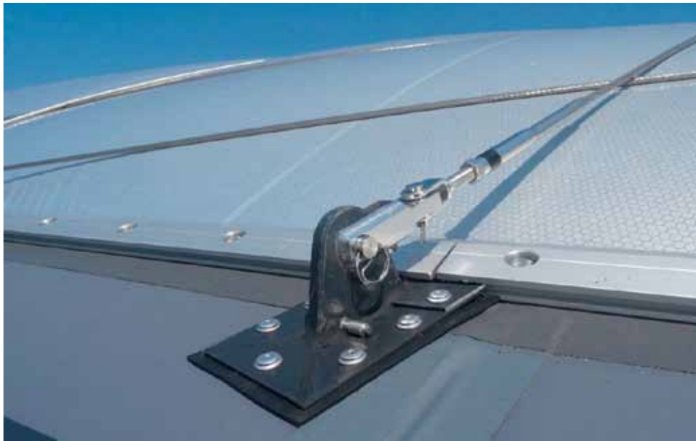
Anschlusspunkt der zugbeanspruchten Seilumspannung
