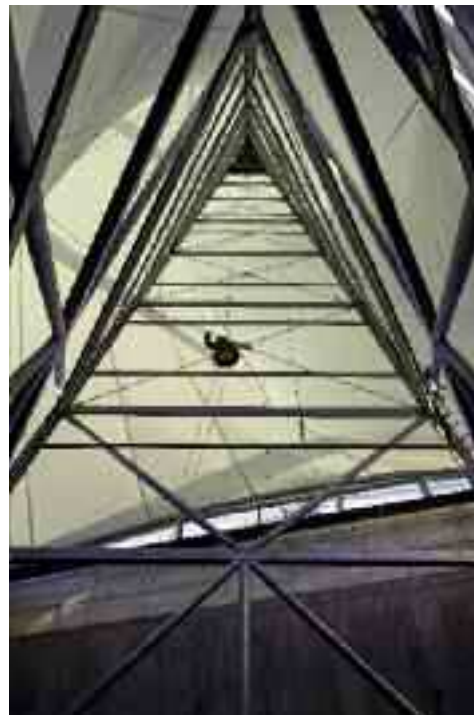
Einbau der Seile © Alexander Ring
