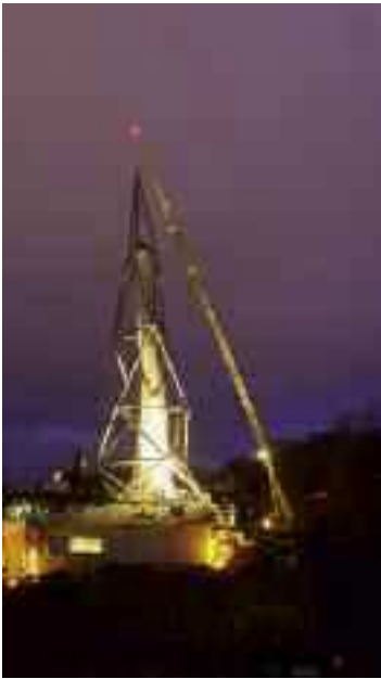
Montage der Membranhelix per Autokran © Alexander Ring
