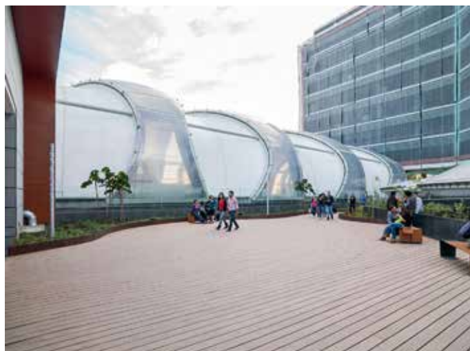
Abb.: Der 109 m lange »Main Dome« überspannt die zentrale Halle. Hier gleicht kein Stahlträger dem anderen und nur wenige Membran- und Kissenzuschnitte haben die gleiche Form.
