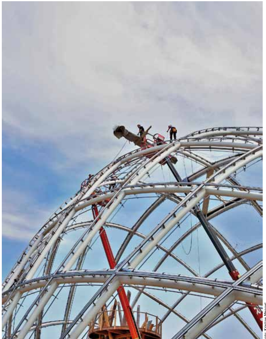
Das Tragwerk besteht aus 10 Stahlbögen, die sich um eine Längs- und eine Querachse auffächern und so ein Netz aus unterschiedlich großen Viereck-Feldern spannen
