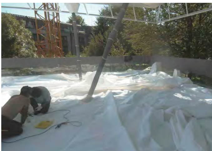
1 Verschweißen der Baustellennähte
