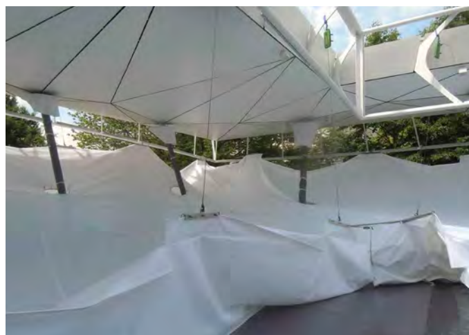
2 Die Membrane wird mittels der Hilfskeder fixiert und angehoben
