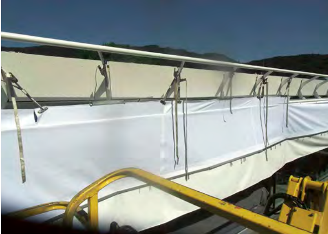
3 Spannen der Membran-Unterseite mittels Hilfskeder
