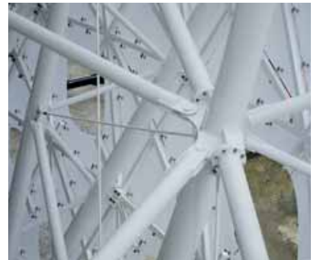
Detail Lagerung K-Verband © formTL
