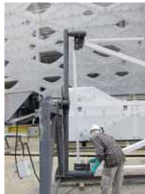
Vormontage Fassadenelement © formTL
