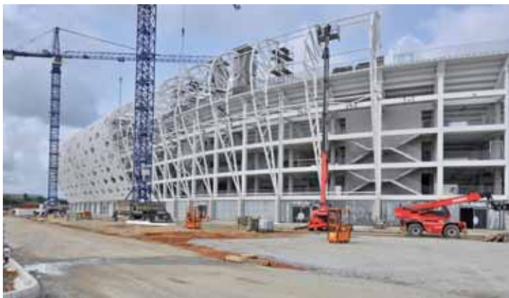
Montage Hülle, Tragstruktur © Julius Berger Nigeria Plc
