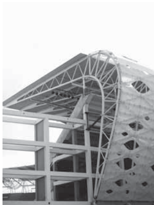
Binder und Fassade Achse 28 Montagezustand © formTL
