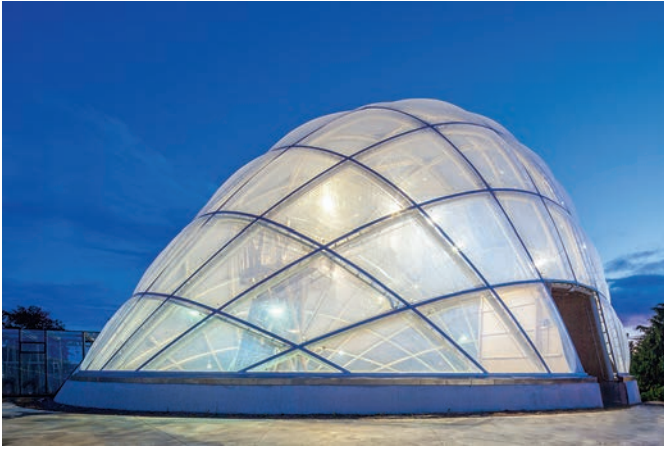
Bild 3. Die ETFE-Kissen sind teilweise mit integrierter pneumatischer Verschlattung versehen (Fotos 1 und 3: Hothouse-Aarhus/Quintin Lake)
