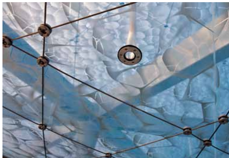
Zusammen mit dem Designer Paolo Monaco entwickelten die Architekten ein auf die Größe der Druckwalze abgestimmtes Seifenblasen-Muster
