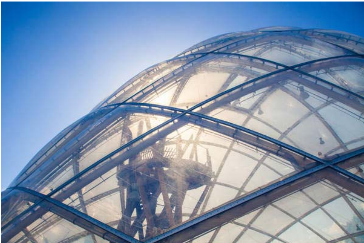
Die ETFE-Kissen sind teilweise mit einer integrierten pneumatischen Verschattung versehen. Foto: Quintin Lake
